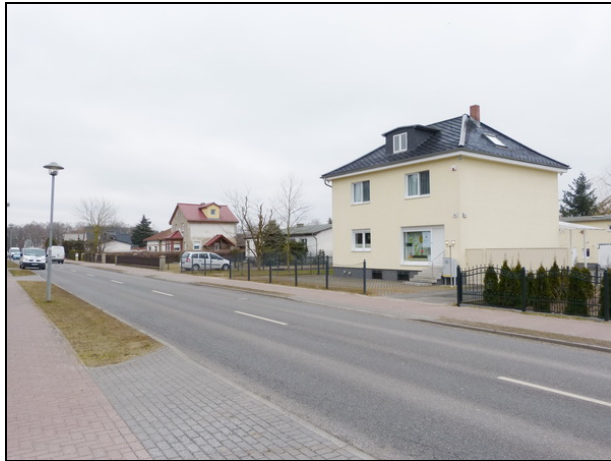
gemischt genutztes Gebäude an der Veltener Straße (Wohnen und gesundheitliche Dienstleistungen)
